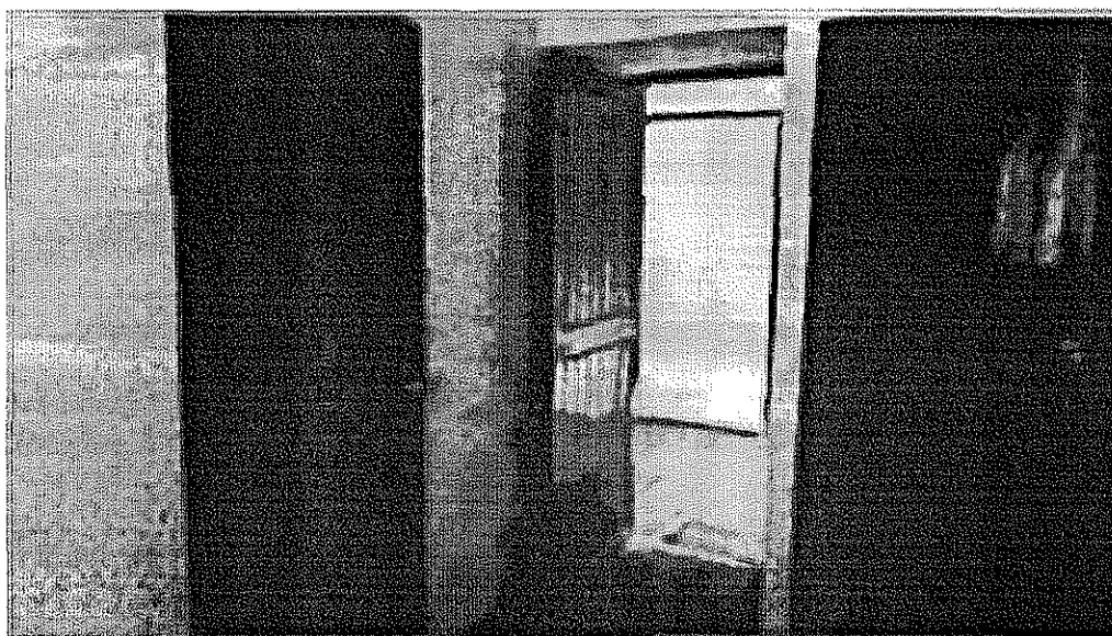
La puerta abierta es la de acceso al cuarto.
